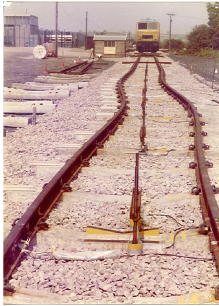
FIG. 7.3: Flambage de rails
